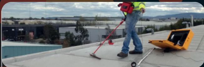
Бесплатное обследование вашей кровли
