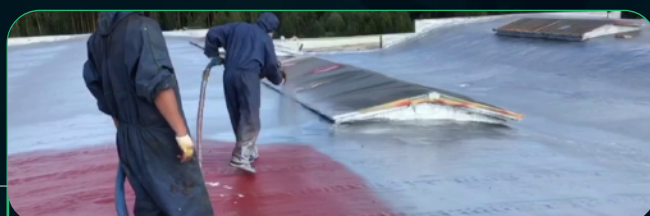
Приезжаем на 3 год и наносим защитное покрытие
