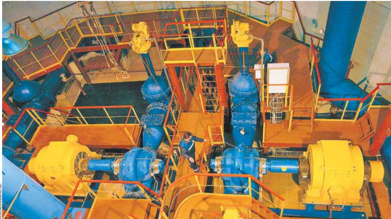
Машинный зал реконструированной водопроводной насосной станции Ростовского водоканала
